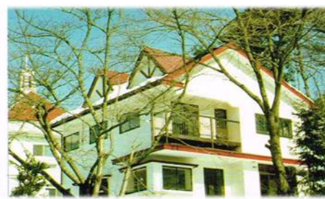
卒園生の宿泊施設アントニー・ホーム
