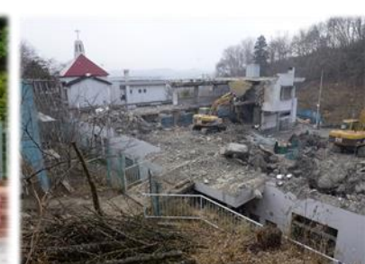
解体が進む園舎
